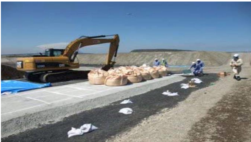
写真ー1 最終処分場①（ベントナイトを敷いた上にフレコンバッグ梱包した飛灰処理汚泥を置く）
