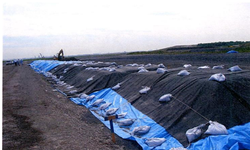
写真ー2 最終処分場②（覆土の上にブルーシート、遮水シート及び土嚢を置く）
