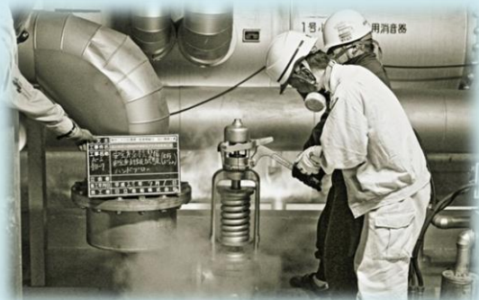
写真①安全弁の検査の様子
