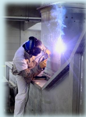
写真②コンベヤ補修工事の様子
